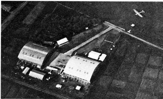
【写真4】 日本航空輸送の格納庫形状変遷例。上は昭和4年6月に竣工の立川飛行場西地区の格納庫で、丸屋根(『日本地理大系関東編』から)。なお、日本航空輸送の定期便運航開始に合わせてこの時期に建てた格納庫は、太刀洗や大連・周水子など、すべてが丸屋根である。
